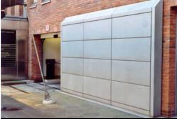
Abbildung 28: Dieses Schiebetor schützt die Garage vor dem Wasserdruck bei Sturmflut (Quelle: Egli Engineering)
