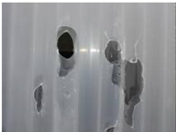
*Abbildung 14: Perforation von Lichtbändern aus Kunststoff (Quelle beider Bilder: Gebäudeversicherung Kanton Zürich)*
