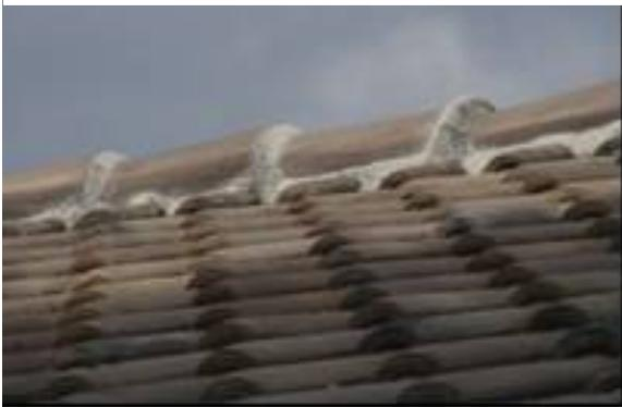
Abbildung 12: Firstziegelvermörtelung (Quelle: D. Aller)
