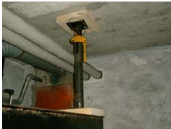
Abbildung 30: Sicherung gegen Aufschwimmen bei einem Öltank aus Stahl (Quelle: P. Corbat)
