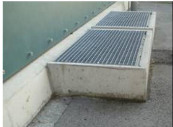
Abbildung 23: Erhöhte Anordnung des Lichtschachtes (Quelle: Egli Engineering)
