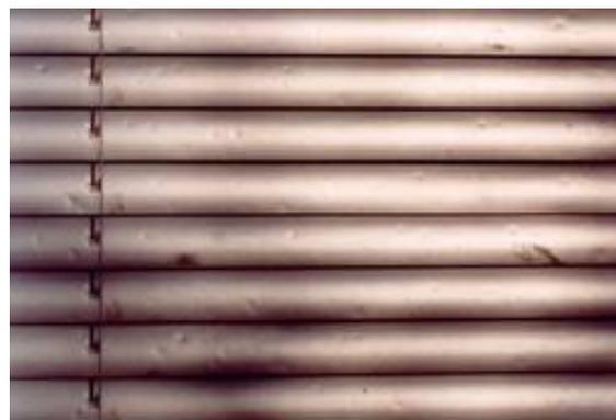
*Abbildung 19: Beulen an Rafflamellenstoren (Quelle: Egli Engineering)*
