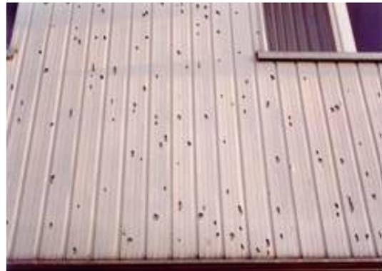
*Abbildung 18: Perforation von Fassadenplatten aus Kunststoff (Quelle: Egli Engineering)*
