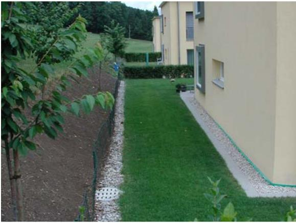
Abbildung 25: Einbau einer Sickerleitung mit Schachtöffnung angrenzend an eine ansteigende Wieslandfläche (Quelle: Gebäudeversicherung Kanton Zürich)
