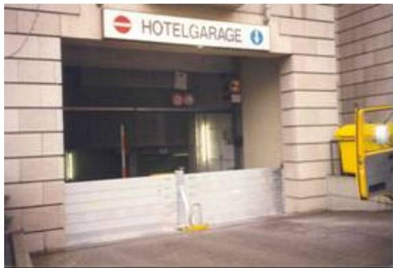
Abbildung 29: Dammbalkenverschlüsse vor der Tiefgaragenzufahrt (Quelle: RS Stepanek)
