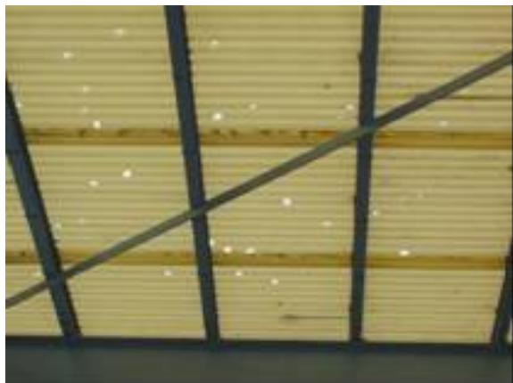
*Abbildung 13: Perforation von Wellplatten*
