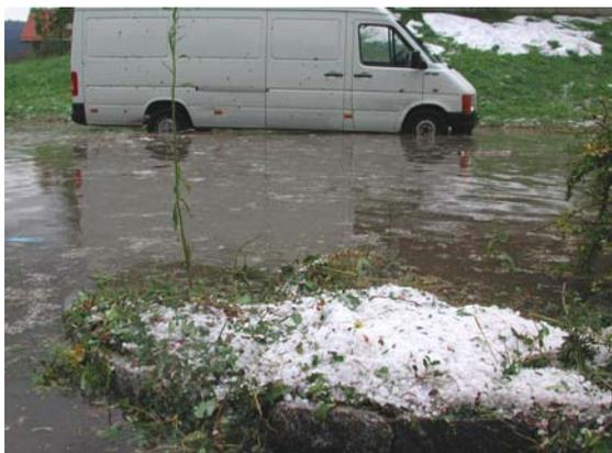
Abbildung 2: Hagel verstopft Entwässerungseinrichtungen und führt so zum Einstau auf Strassen (Quelle: Egli Engineering)
