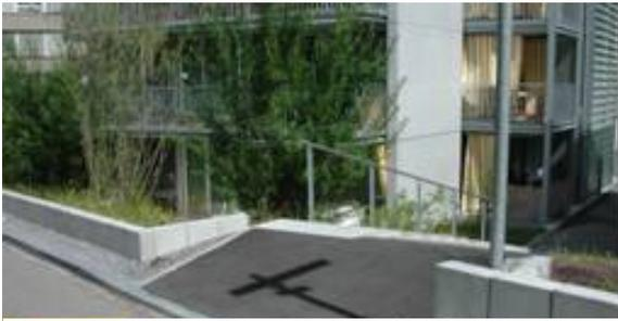
Abbildung 24: Diese Rampe verhindert den Zufluss von Straßenwasser über den Treppenzugang (Quelle: Egli Engineering)
