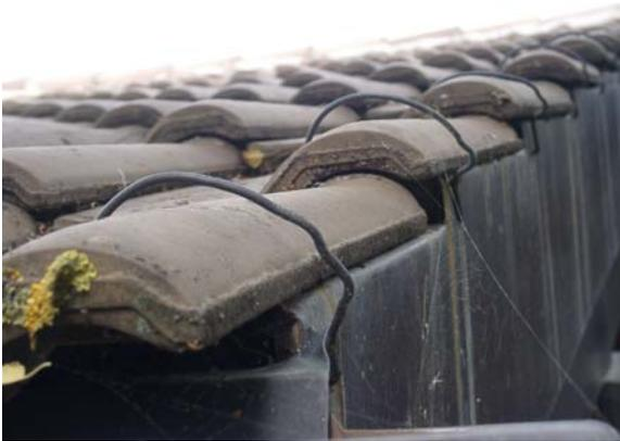
Abbildung 11: Sturmklammerung (Quelle: D. Aller)
