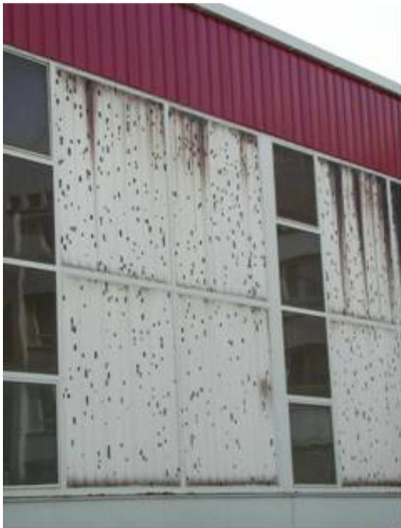
*Abbildung 17: Perforation von Fassadenplatten aus Kunststoff (Quelle: Gebäudeversicherung Kanton Zürich)*
