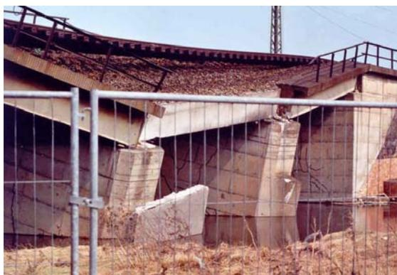
Abbildung 5: Einsturz einer Bahnbrücke bei der Elbeüberschwemmung 2002. Die Brücke wurde vermutlich nicht gegen dieses Gefährdungsbild bemessen, da sie sich bei
