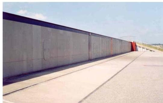
Abbildung 6: Hochfahrbarer Deichverschluss auf dem Betriebsgelände der EADS in Hamburg. Abgesenkter Zustand.
