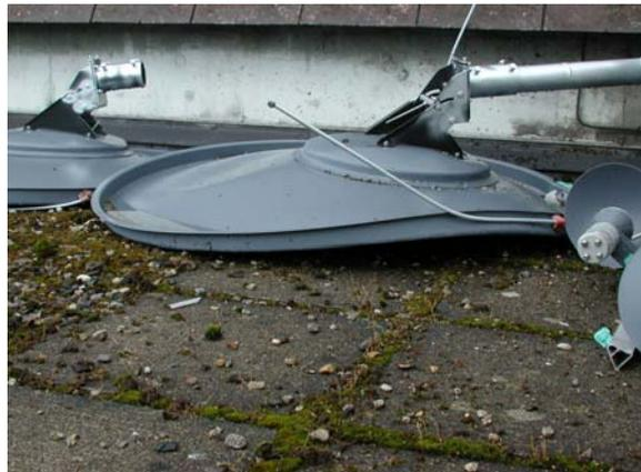
*Abbildung 8 Abgerissene Satellitenantenne (Quelle von Abb. 7 und 8: Gebäudeversicherung Kanton Zürich)*
